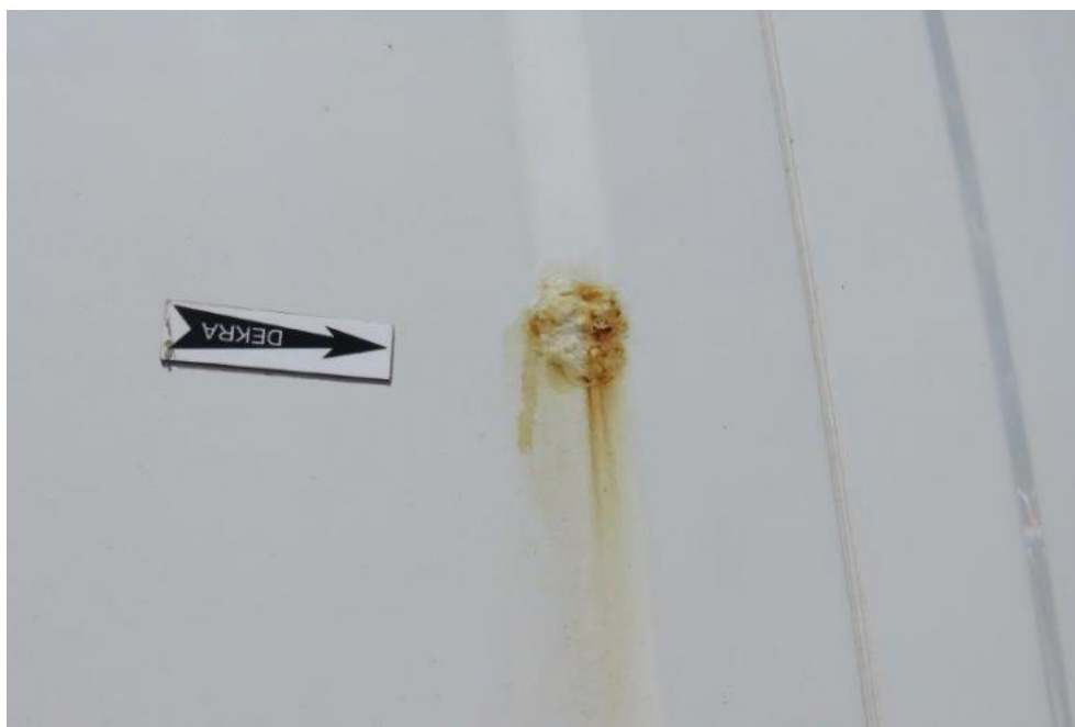
Fot. 33. ściana lewa
