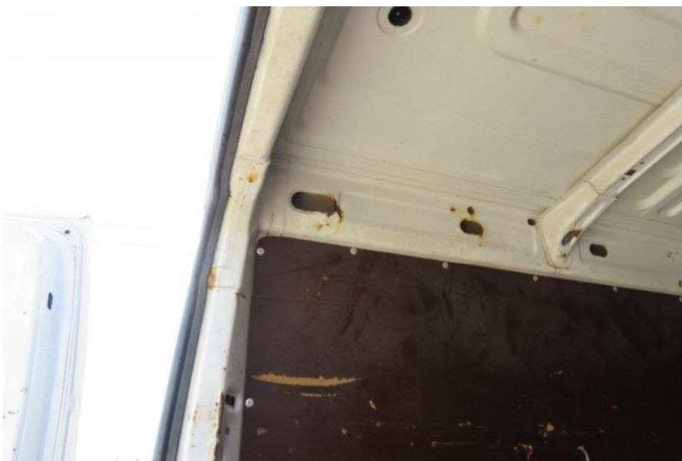
Fot. 50. ściana wew. TL
