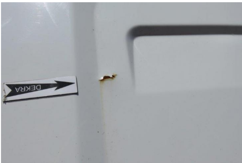
Fot. 32. ściana lewa
