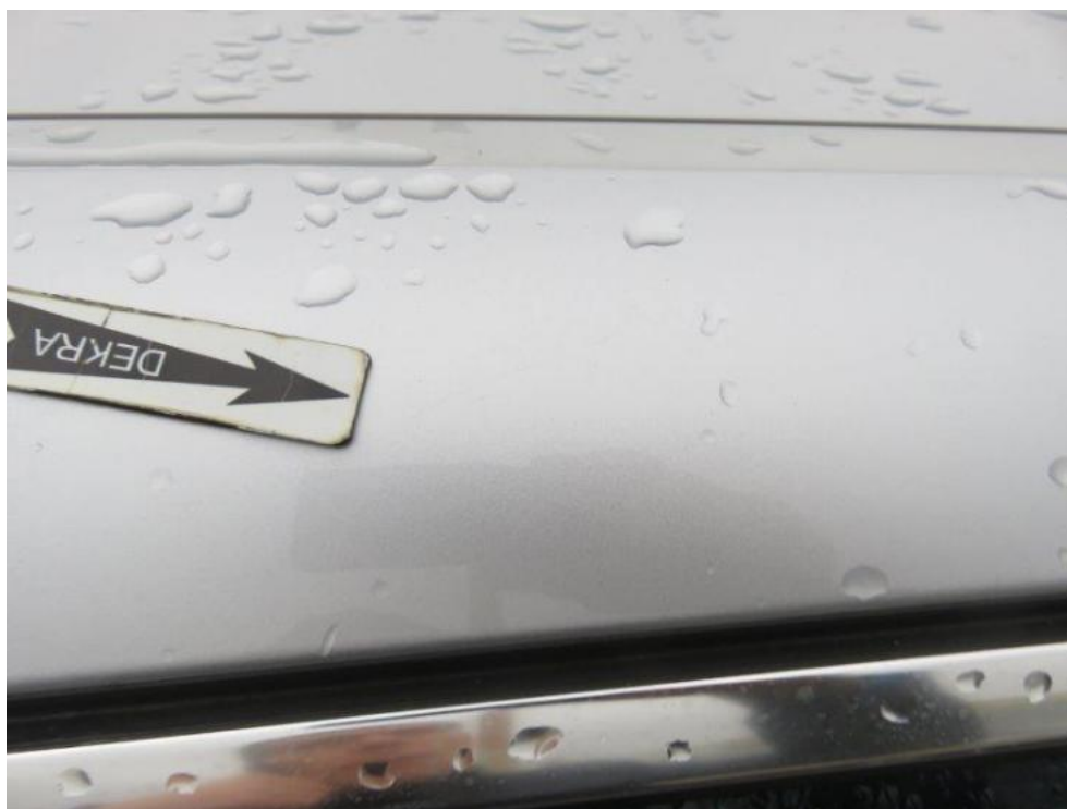
Fot. 45. rama prawa dachu
