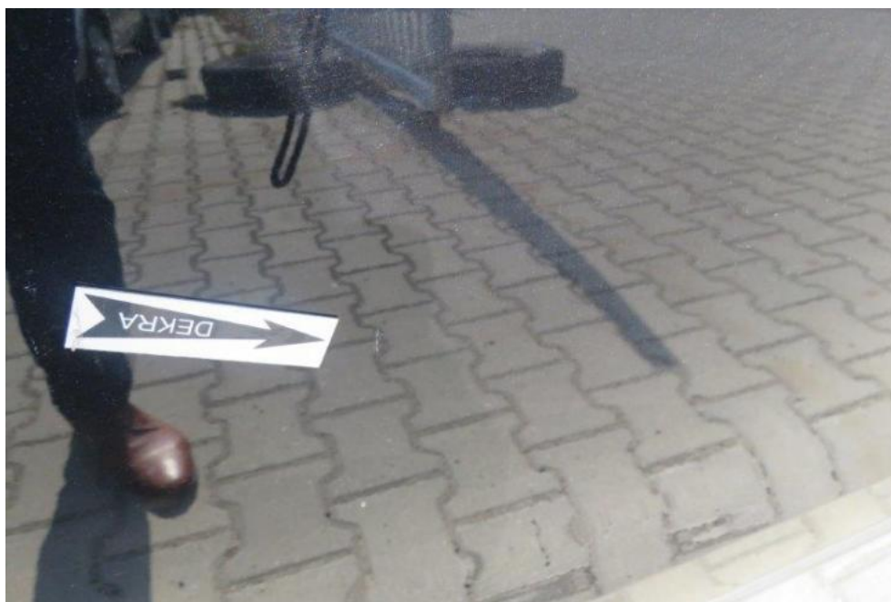
Fot. 57. drzwi PR
