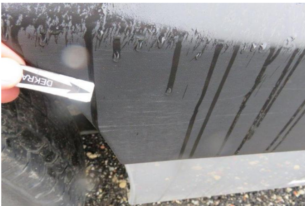
Fot. 41. ściana prawa
