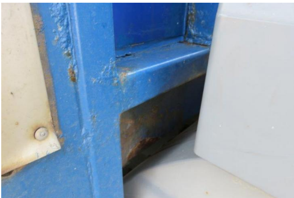
Fot. 44. zabudowa przód
